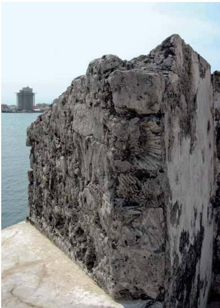
Hasta que se dispuso de la piedra de las canteras de Xalapa, se utilizaría en la construcción de San Juan de Ulúa el material de los arrecifes coralinos con sus interesantes texturas y sus complejos resultados técnicos
