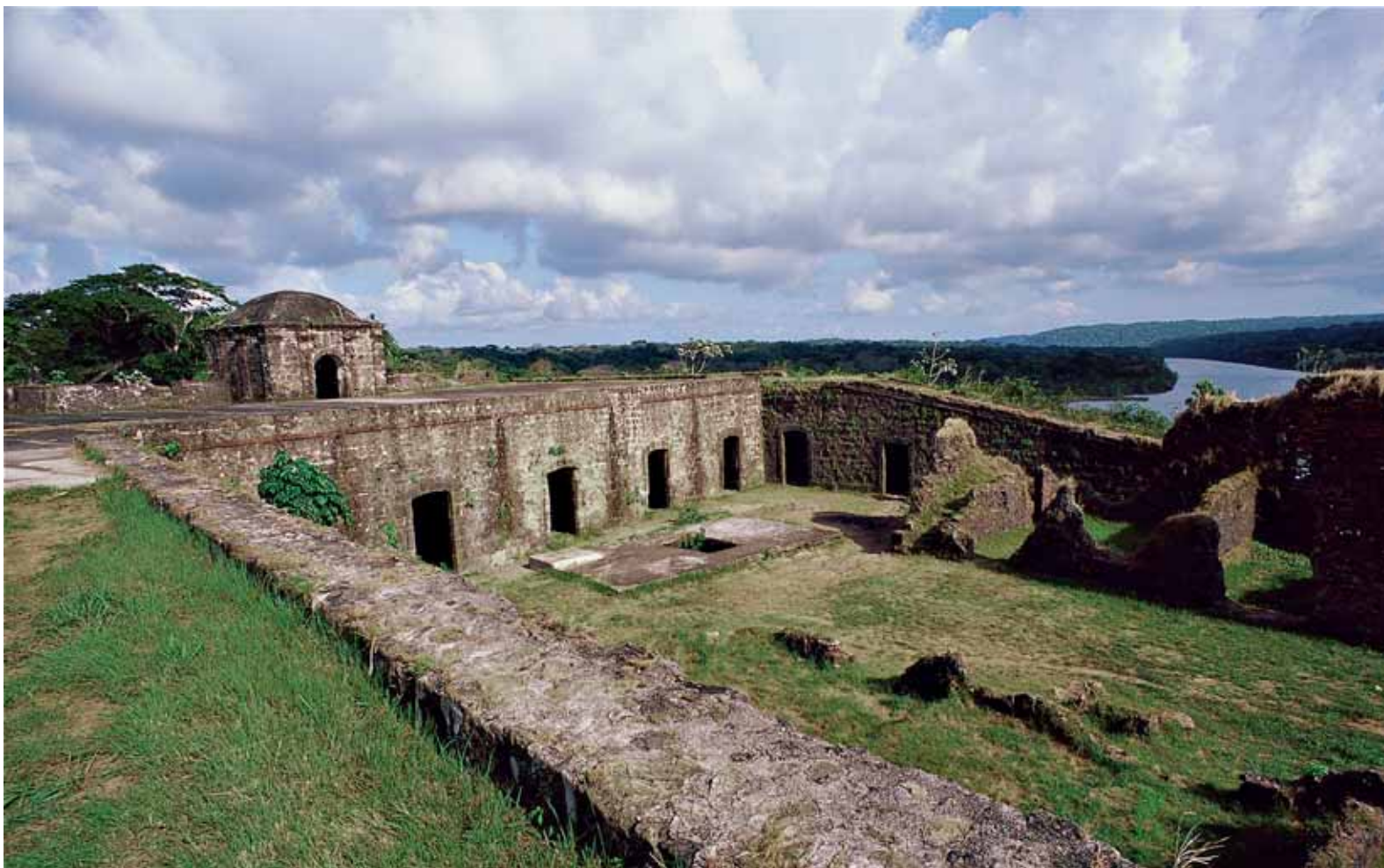
El patio de San Lorenzo el Real de Chagre evidencia la imponente obra de piedra dispuesta para controlar el acceso fluvial hacia Panamá
