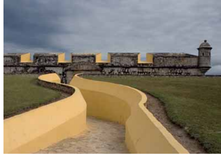
Fortín de San José, ubicado en una lomada que facilitaba el control de la campiña y con un camino cubierto zigzagueante para el acceso
