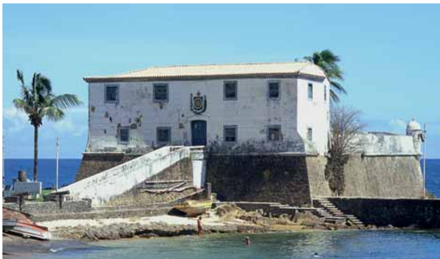
El reducto de Santa María estaba ubicado en un lugar prominente frente a la playa y constituía una casa fuerte con dos baluartes, cuyo objetivo era dificultar el desembarco del enemigo
