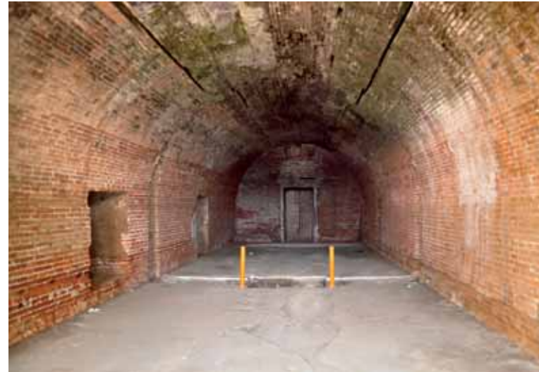
Bóvedas de ladrillo correspondientes a las baterías realizadas en Valparaíso a fines del siglo XVIII
