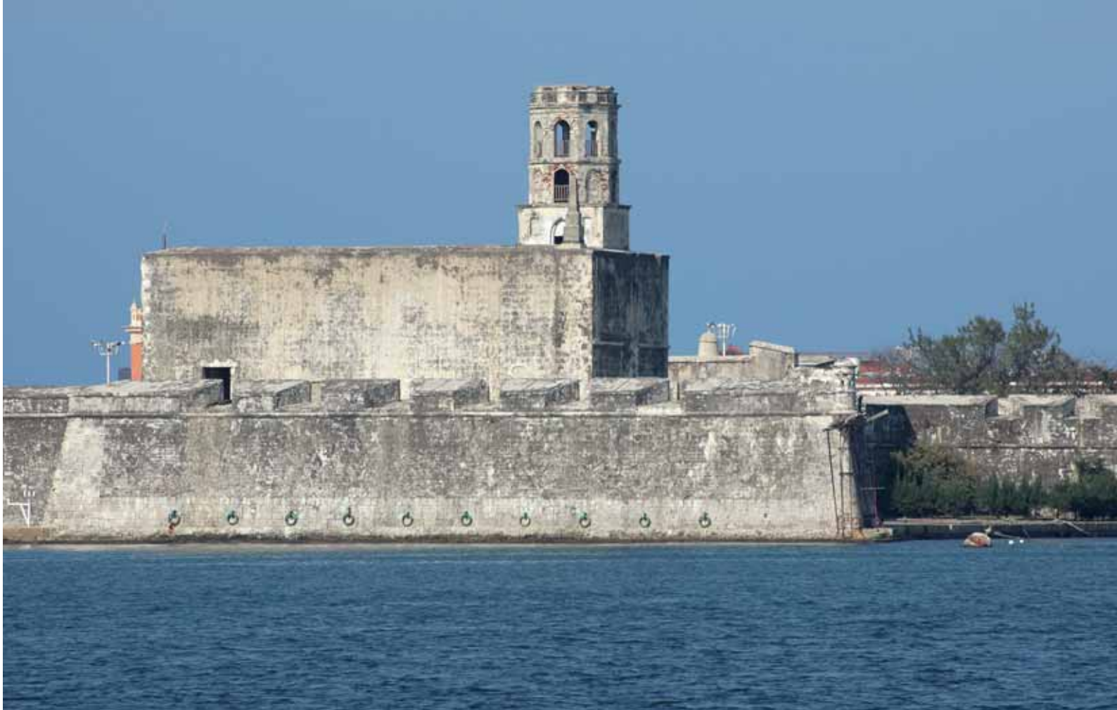
Del muro de las argollas a las adiciones de los siglos XVII y XVIII podemos apreciar la evolución compleja del sistema fortificado y la importante inversión económica que significó su construcción a través del tiempo
