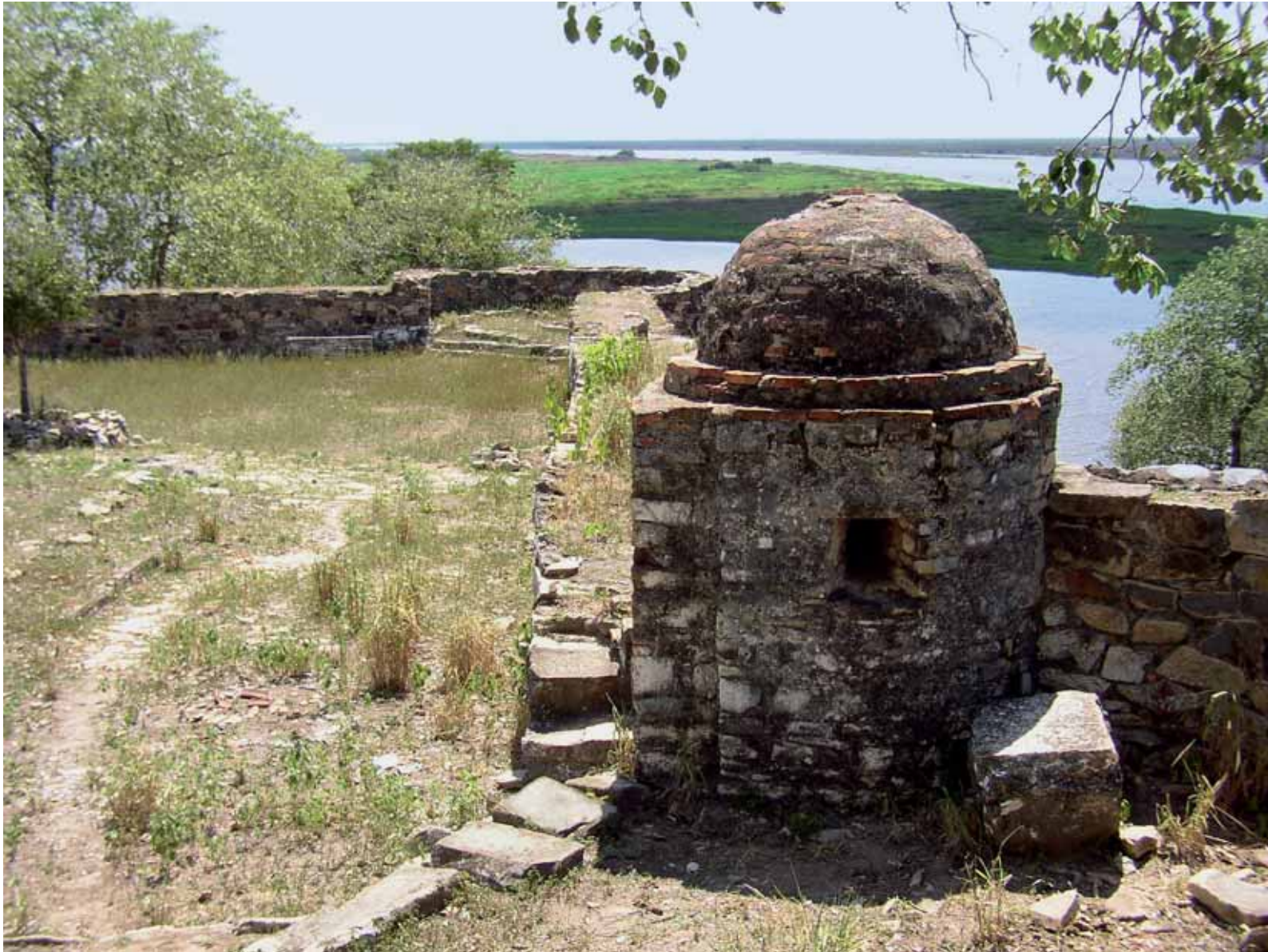
Baluartes y garitas subsistentes del fuerte Borbón después de su consolidación en piedra y ladrillos
