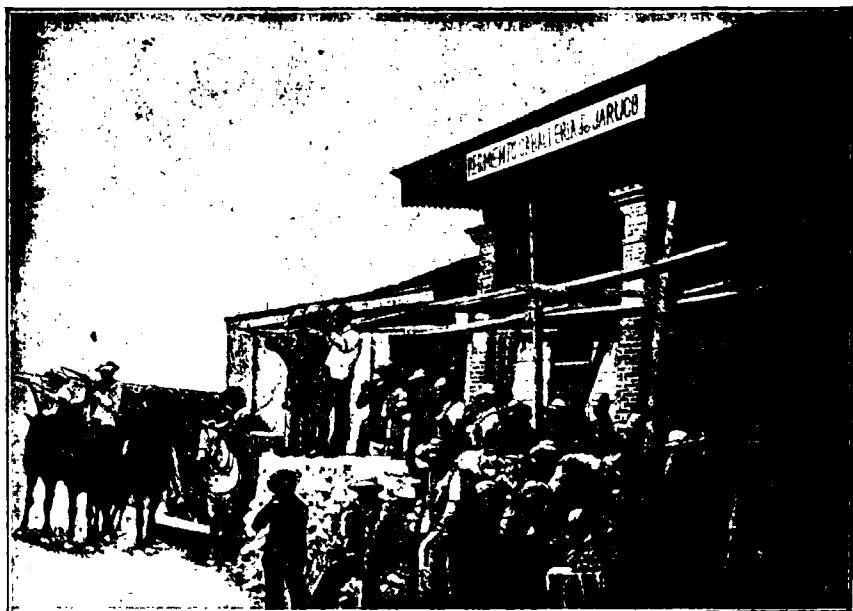
Grupo de Voluntarios del Regimiento Caballería de Jaruco defendiendo el frente de la Casa cuartel del primer Escuadrón movillizado, en la noche del 18 Febrero 1896
